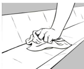
Todos os substratos devem estar secos. Limpe e remova qualquer gordura dos substratos utilizando o Effisus Cleaner. Certifique-se de que qualquer revestimento do substrato está em boas condições, caso contrário, remova-o. A junta da calha deve ser fixada mecanicamente (com rebites, soldadura, etc.) para que a união entre as duas secções da calha seja assegurada antes da instalação do sistema de vedação da junta. Qualquer parafuso ou rebite utilizado deve ter uma cabeça plana.
