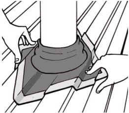
Posicione o Effisus Stopper MR de forma a que este forme um losango em relação ao canelado da cobertura (como na imagem).
