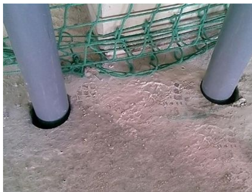
Imagem 8 – Condução de drenagem de águas pluviais
