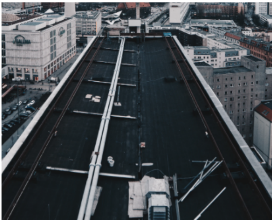
Imagem 1 – Instalação de condutas de ventilação em coberturas
