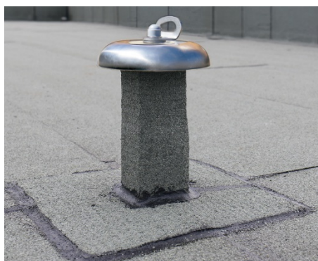
Imagem 2 – Fixação de perno estrutural para suporte
