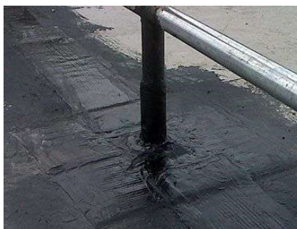
Imagem 5 - Fixação de guarda corpo
