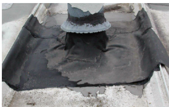
Imagem 11 – Selagem deficiente de atravessamento na cobertura
