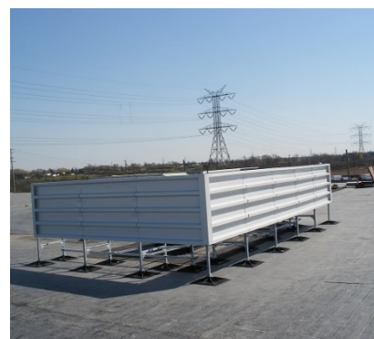
Imagem 3 – Estrutura de proteção fixada na cobertura
