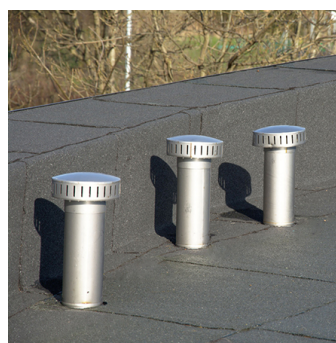
Imagem 12 – Atravessamento de condutas de ventilação
