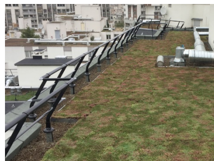
Imagem 6 – Diversas perfurações numa platibanda de cobertura
