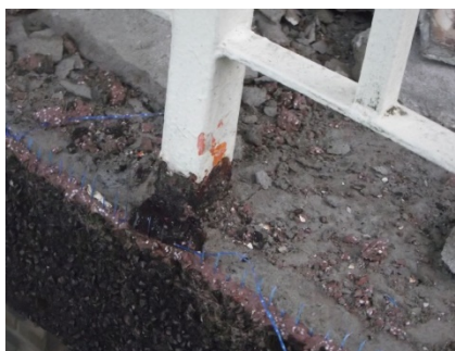
Imagem 4 – Fixação de guarda corpo numa tela de cobertura
