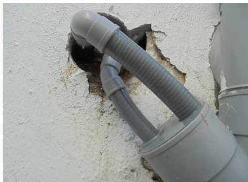
Imagem 9 – Atravessamento de tudo corrugado na fachada
