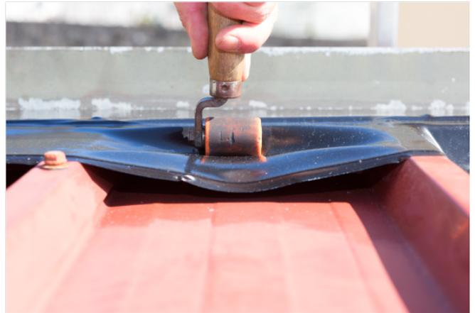
Se trata de una solución de sellado definitivo para conexiones y remates en cubiertas metálicas de cualquier tipo, garantizando ahorro de tiempo y mano de obra – con un rendimiento superior y una durabilidad igual a su cubierta. Su capacidad única de estiramiento y flexibilidad garantizan que se amolde y se adapte completamente a superficies y formas irregulares, sin necesidad de fijación mecánica, calor o adhesivos extra.
