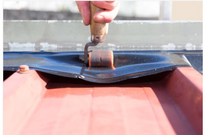
É uma solução definitiva para selagem de conexões e remates em coberturas metálicas de qualquer tipo, garantindo poupanças de tempo e mão de obra – com um desempenho e performance superior. A sua capacidade única de alongamento e flexibilidade garantem que esta se adapta completamente a superfícies e formas irregulares, sem necessidade de fixação mecânica, fogo ou adesivos extra.
