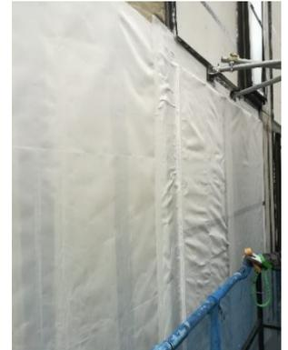
Fig.9 - Proyecto Effisus – Reino Unido: donde se está instalando el sistema completo Effisus Ecofacade Envelope
