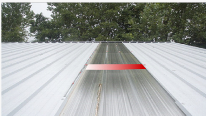
3 – Selagem de juntas entre placas de polycarbonato
