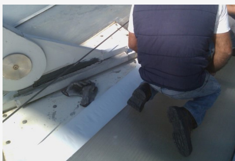
1 – Estádio de futebol – Juntas entre placas de policarbonato e metal
