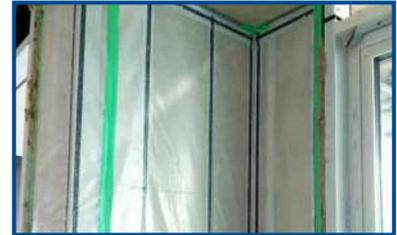
A Membrana Effisus VapX é uma barreira de vapor de qualidade superior e multifuncional para fachadas e aplicações em interiores em geral. Permite a obtenção de uma barreira de estanquidade ao ar e vapor de água que melhora a eficiência energética e evita as condensações superficiais.
