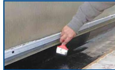
O Adesivo Effisus Bonding KT é uma cola de contacto pronta a utilizar para a colagem das membranas Effisus Ecofacade, sobre todos os substratos minerais de construção (betão, betão celular, arenito calcítico, tijolo, clínquer, argamassa), PVC, alumínio ou madeira. Adequado para substratos lisos e uniformes. Em combinação com o Effisus Coat NP Primer, as operações de colagem podem ser executadas sob temperaturas até -10°C e em substratos de construção húmidos.
