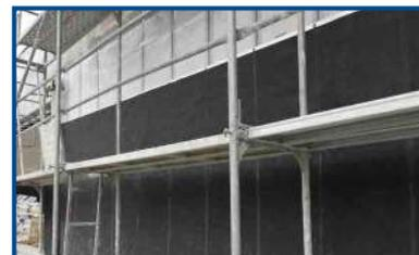
Membrana respirável com base em microfibras de polipropileno para controlo da humidade/vapor e protecção à água em fachadas ventiladas, promovendo a sua eficiência energética e minimizando condensações superficiais.
