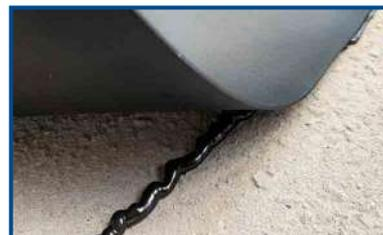
O Adesivo Effsus Bonding KF é um adesivo em pasta recomendado para colagem das Membranas Effsus Ecofacade sobre os mais diversos substratos, como betão, alumínio, PVC, metal, entre outros. Com excecional força de aderência é especialmente indicado para colagem sobre superfícies irregulares / rugosas.
