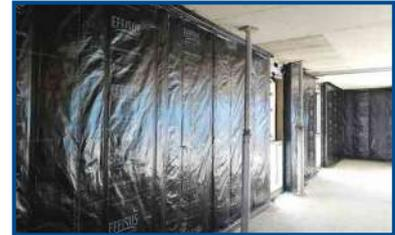
A Effsus Vapour FR é uma barreira pára-vapor multifuncional e de alta qualidade feita a partir de uma tecnologia especial de fibra de vidro e alumínio, desenvolvida para atingir uma classificação de reação ao fogo A2-s1,d0 de acordo com a norma EN13501-1. Esta classificação foi obtida para a membrana Effsus Vapour FR incluindo os acessórios de fixação Effsus (fitas e adesivos) testado em sistema totalmente exposto ao fogo.
