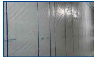
A membrana Effisus Vapour Reinforced é composta por três camadas, reforçada com uma malha em polietileno. Usada normalmente como barreira pára-vapor em fachadas, coberturas e em interiores, com a finalidade de promover estanquidade ao ar e vapor de acordo com a norma EN 13984.
