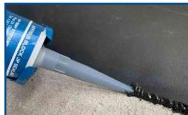
O Selante Effisus Block JP é um selante de componente único que, cura sob a influência da humidade, transformando-se num selante permanentemente elástico e resistente a intempéries. O selante Effisus Block JP é altamente resistente ao envelhecimento por raios UV's e a todas as condições climáticas associadas. O seu componente antifúngico fornece proteção contra a maioria dos microorganismos que aparecem em interiores húmidos. livre de odores.
