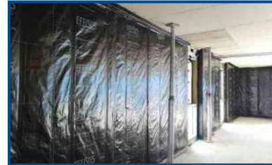
A Effisus Vapour FR é uma barreira pára-vapor multifuncional e de alta qualidade feita a partir de uma tecnologia especial de fibra de vidro e alumínio, desenvolvida para atingir uma classificação de reação ao fogo A2-s1,d0 de acordo com a norma EN13501-1. Esta classificação foi obtida para a membrana Effisus Vapour FR incluindo os acessórios de fixação Effisus (fitas e adesivos) testado em sistema totalmente exposto ao fogo.
