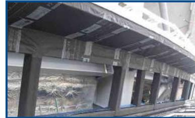
Uma membrana inovadora com uma tecnologia funcional TEEE avançada para gestão da humidade e proteção à água e vento em fachadas, promovendo a sua eficiência energética e minimizando condensações – altamente permeável ao vapor de água, mas 100% impermeável à água da chuva e resistente ao vento.
