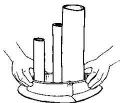
Colocar a secção do molde com o selante/adesivo já aplicado na posição pretendida já marcada no passo 2. Pressionar firmemente até que o selante surja na aresta exterior. Colocar a segunda secção do molde na posição marcada de forma a obter um anel contínuo em volta do atravessamento e pressionar firmemente. Aplicar um cordão contínuo de Selante Effisus Stopper M-1 no perímetro de todo o molde exterior. Alisar as juntas e o selante aplicado com a ajuda de uma espátula.
